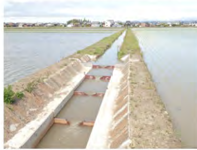
堰上げ式の魚道
