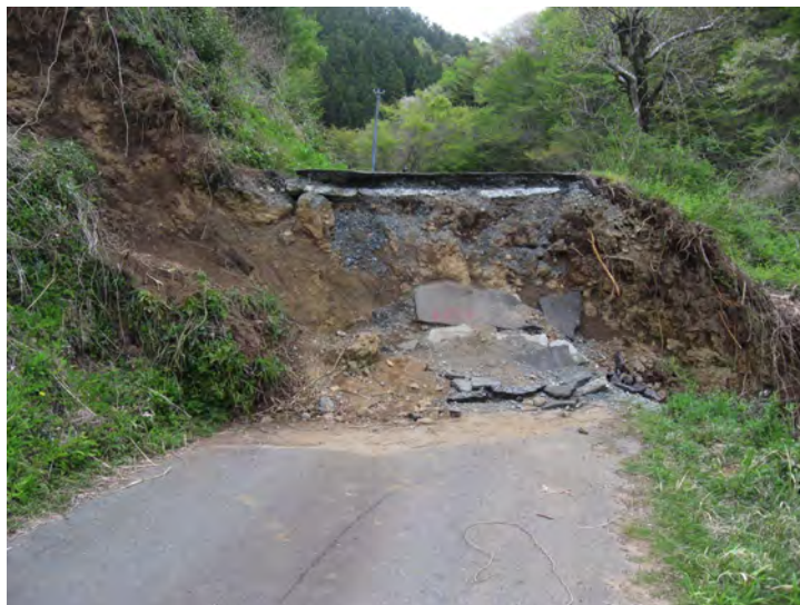
図2 2011年4月11日に発生した直下地震「福島県浜通りの地震」で出現した地表地震断層 （2011年5月、いわき市塩ノ平で撮影）
