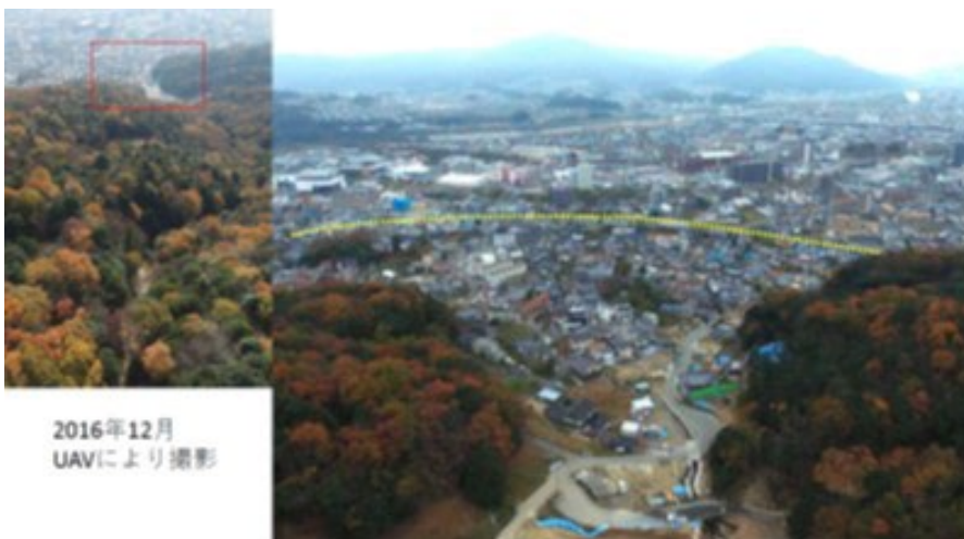
図3 土石流扇状地における被害の例 (広島市安佐南区緑井にて八反地ら撮影)
