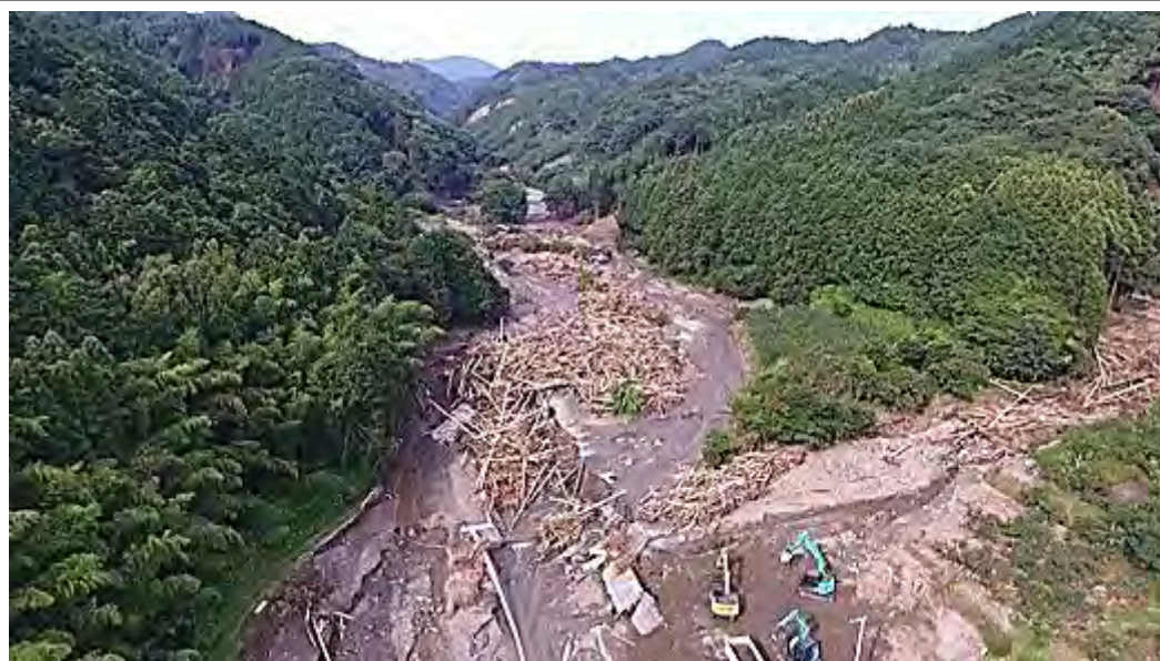
図5 朝倉市山田地区の洪水・土砂氾濫の様子 (2017年7月13日撮影)
