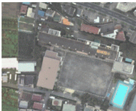
図3 真上から見た学校の校舎 地理院地図 空中写真
